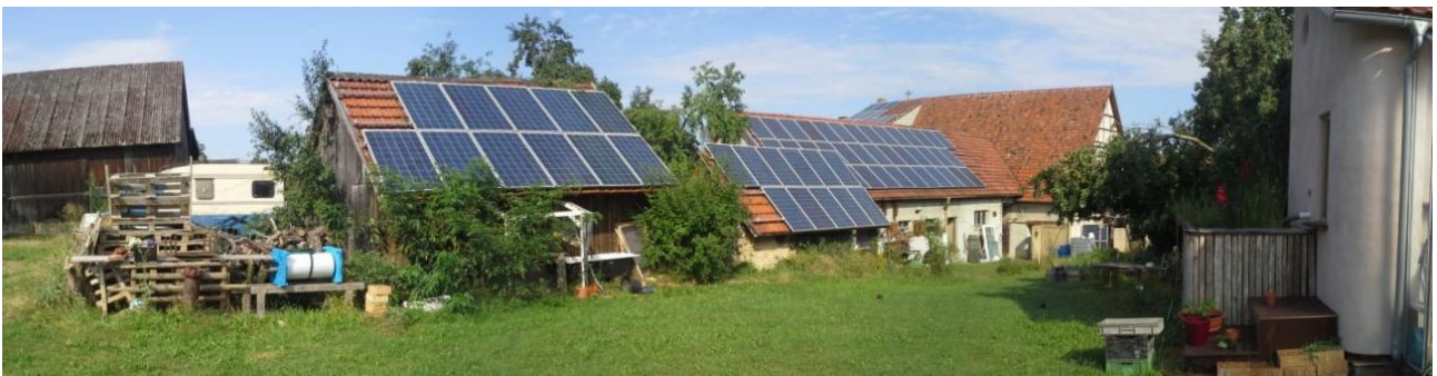
Abb. 4: Blick auf den westlichen Teil des Untersuchungsgebietes mit Lagerfläche und zwei Schuppengebäuden.
