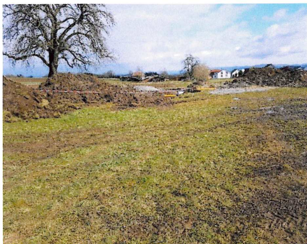
Rohbodenfläche/Baustelle südlich innerhalb des Plangebiets. Blickrichtung Nordosten.
