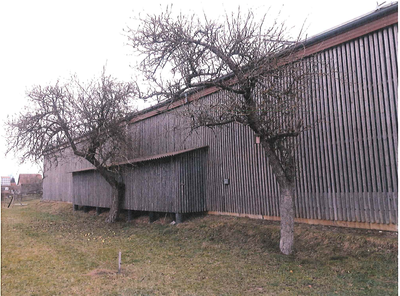
Abb. 8: Betriebsgebäude östlich des Plangebietes mit zwei Apfelbäumen
