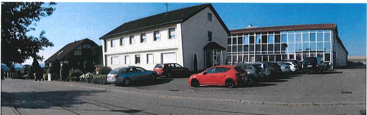
Abb. 3: Das Plangebiet mit Firmen- und Wohngebäuden von Norden betrachtet
