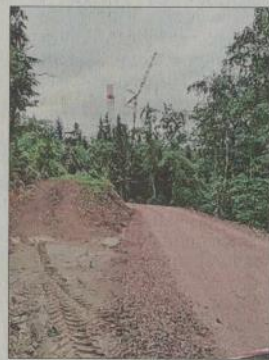
Der Windpark Hohenlochen auf der Zielgeraden. Foto: Badenova
