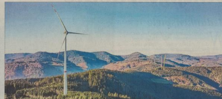
Auf dem Hohenlochen wird zur Zeit ein Windpark errichtet. Vier Windräder sollen dort Energie gewinnen. Archivfoto: Andreas Walry
