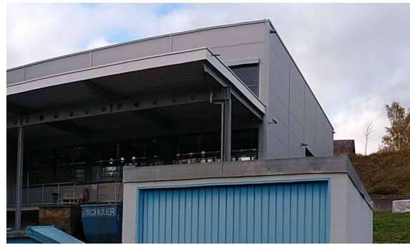
Abb. 26: Attika-Bleche an den Firmengebäuden im Plangebiet
