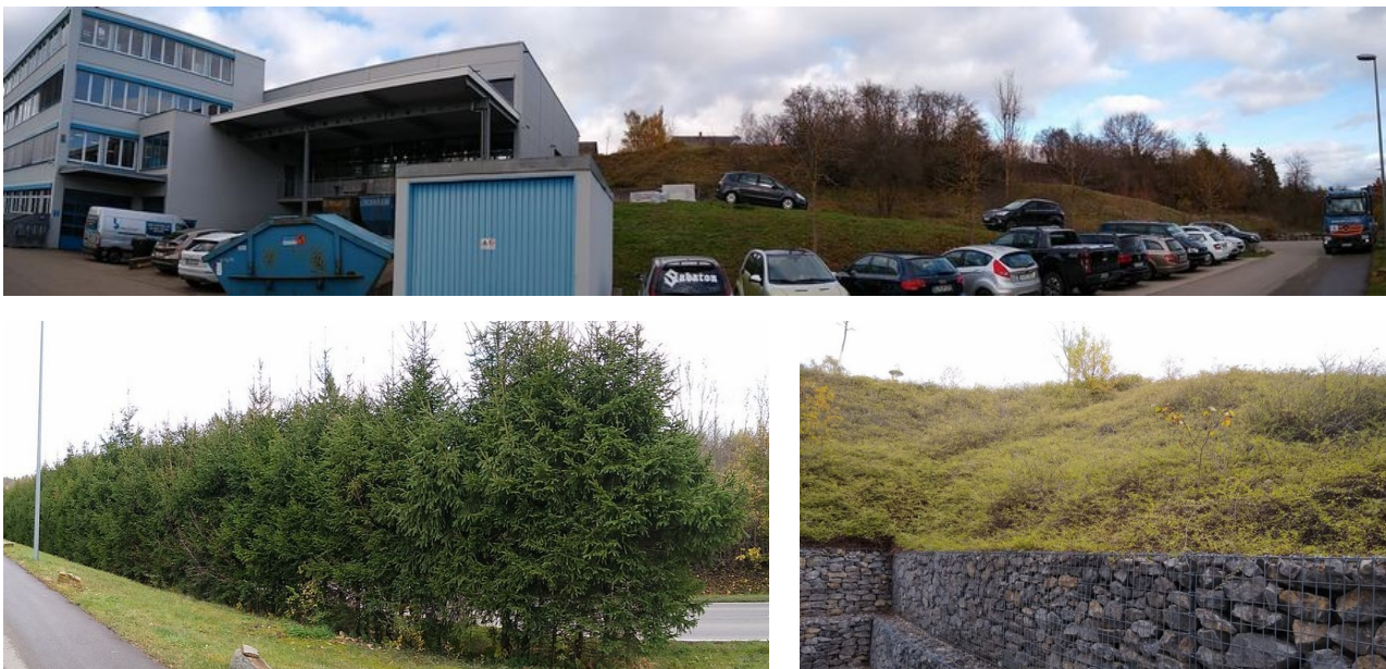
Abb. 4: Oben: Bestehendes Firmengebäude (links), Parkplätze (vorn) und geplante Erweiterungsfläche am Oberhang (mittig und rechts). Unten links: Fichtenhecke zur Abschirmung der angrenzenden Landesstraße südlich des Geltungsbereiches. Unten rechts: Mit Gabionen abgesicherter und mit Purpurbeere bepflanzter Hangbereich hinter dem bestehenden Firmengebäude (Aufnahmen vom 12.11.2019).
