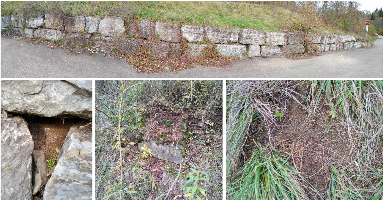
Abb. 54: Habitatpotenziale für die Zauneidechse innerhalb des Plangebietes. Oben : Natursteinmauer als Umgrenzung einer Parkbucht am Unterhang der Wiesenbrache. Unten links : Großes Lückensystem zwischen den einzelnen Mauersteinen mit lockerer Erde. Unten mittig : Natursteinblock innerhalb des Gehölzbestandes. Unten rechts : Lockeres, grabbares Substrat zwischen den horstig aufwachsenden Gräsern in der Brachefläche.
