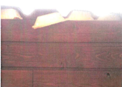
Abb. 13: Zugänge hinter das Wellblech
