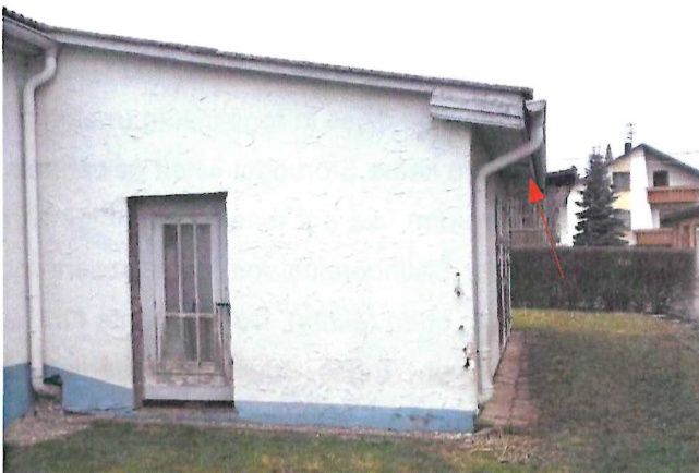
Abb. 18: Frei zugängliches Dachgebälk im Anbau von Gebäude Nr. 3, jedoch ohne Nutzungsspuren und ungeeignet aufgrund von regelmäßigen Störungen durch den laufenden Betrieb (oben links). Isolierter Dachbereich in Gebäude Nr. 3 (rechts oben). Dachverwahrung mit Riss im Holz (roter Pfeil), welcher Zugang ins Innere des Dachbereiches erlaubt (unten links).
