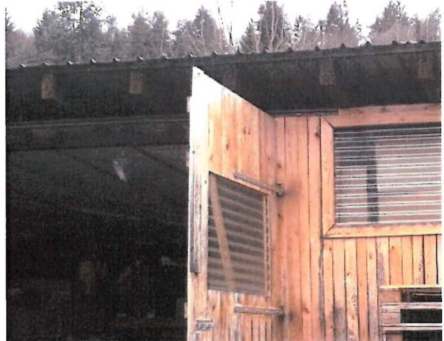
Abb. 17: Dachbereich mit unterhalb der Dachbalken gespannter Plane (links im Hintergrund)
