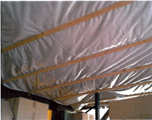
Abb. 16: Mit Plane bespannter Dachbereich von Gebäude Nr. 2
