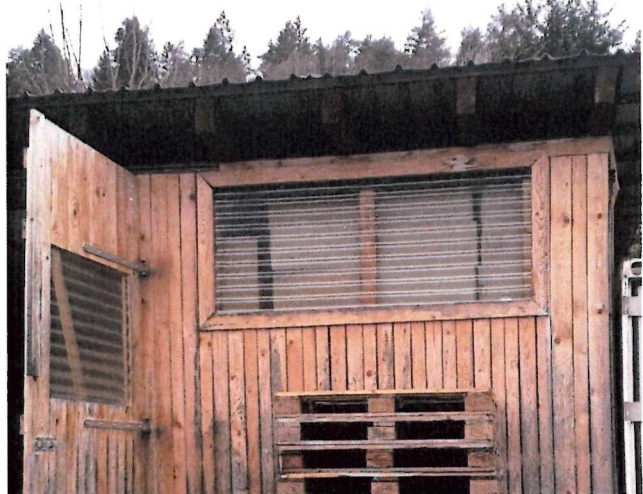
Abb. 22: Absatz unterhalb des Daches von Gebäude Nr. 2 mit Nistplatzpotenzial für Nischenbrüter
