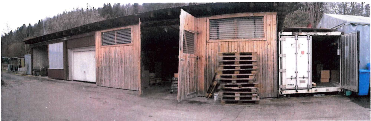
Abb. 8: Gebäude Nr. 2 aus östlicher Richtung betrachtet.
