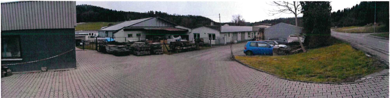
Abb. 3: Einfahrtsbereich auf das Betriebsgelände
